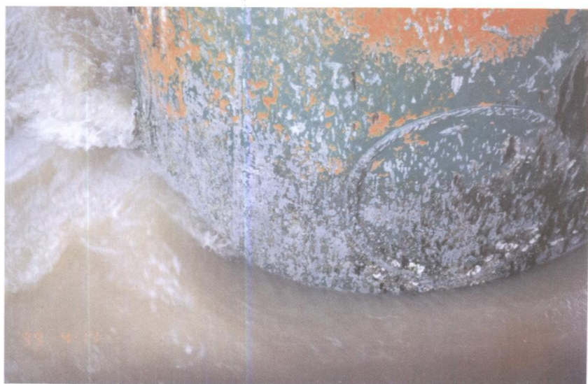
照片7 D、E 桩水线区外侧
