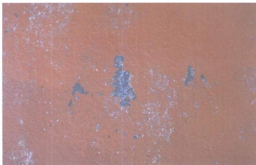
照片5 D、E桩大气区内侧 涂层厚度: 211.5 \mu\text{m}
