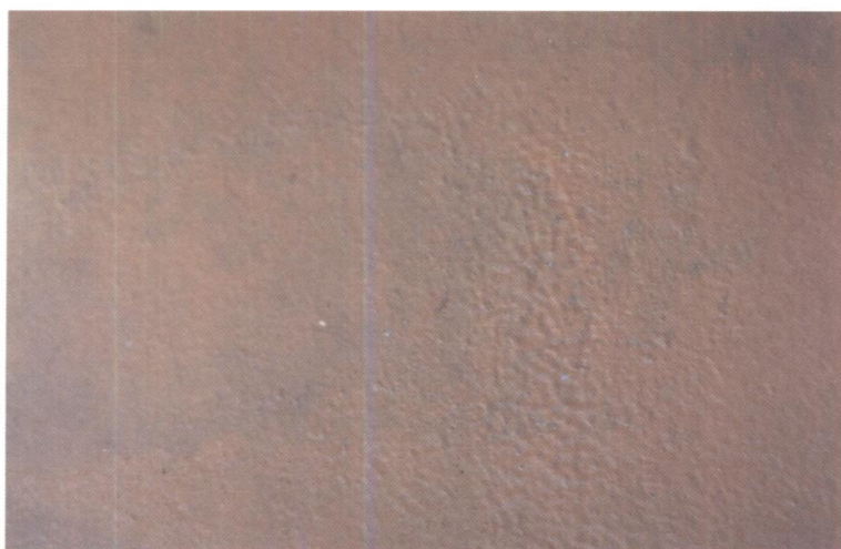
照片1 A、B、C 桩大气区外侧 涂层厚度: 281.6 \mu\text{m}
