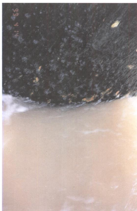
照片 10 F、G 桩水区内侧 涂层电位: -890 mV( 0 m) -920 mV( 0 m)
